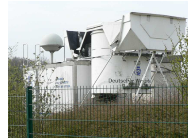
DWD Essen-Bredenev Automatische Wetterstation Sie erfasst ständig: Luft- u. Erdtemperatur, Luftfeuchte, Wind, Niederschlag, Sicht, Wolken, Sonnenscheindauer, Strahlung u. Wetterzustand
